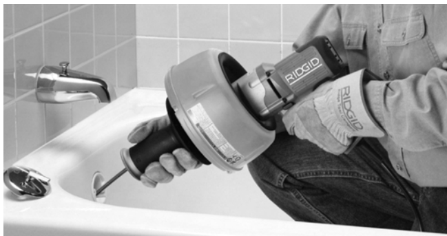
Obrázek 9 - Zasunujte kabel dolů do odpadového potrubí
