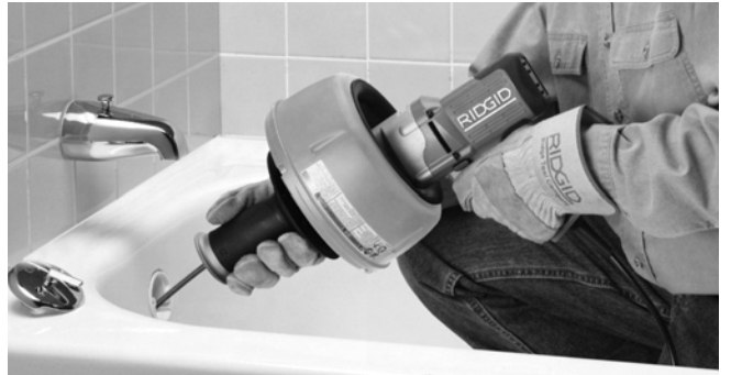
Şekil 9 - Spirali Kanal Hattına İtin
