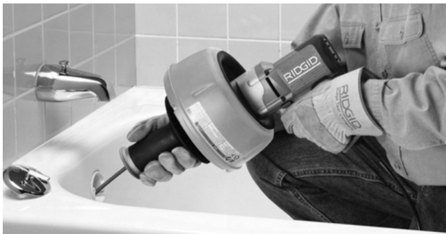
Figuur 9 – Duw veer in afvoerleiding
