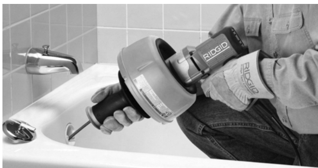
Figura 9 – Împingeți cablul în conducta de canalizare
