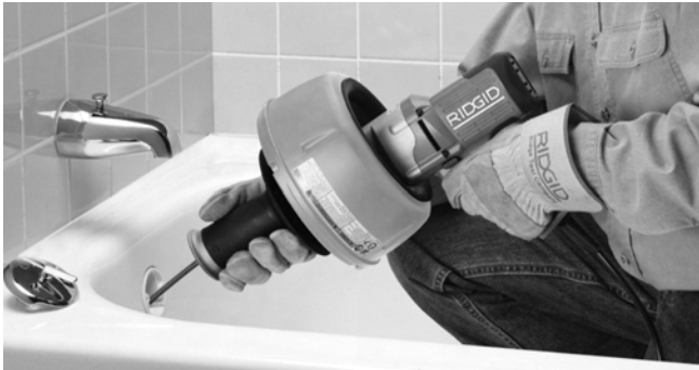
Kuva 9 – Työnnä jousi sisään viemäriin
