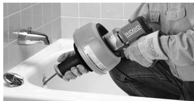
Rysunek 9 – Wpychać sprężynę do odpływu
