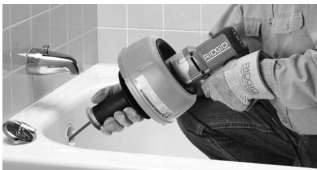
Slika 9 – Kabel potisnite v odtok
