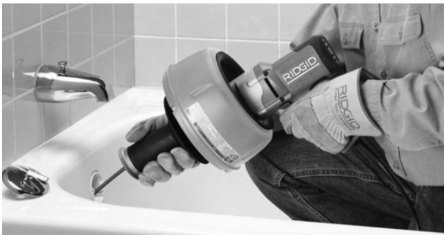
Abbildung 9 – Spirale in den Abfluss schieben
