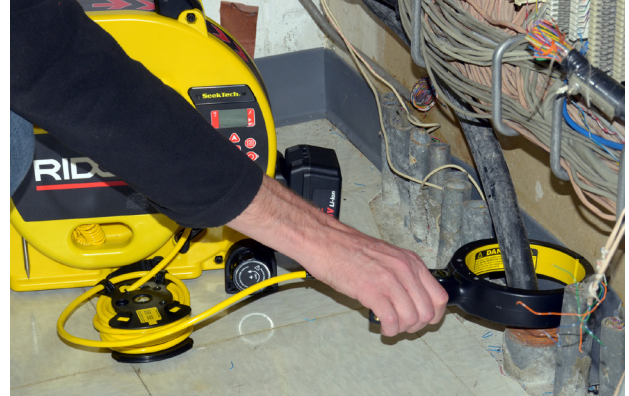
Рисунок 11 – Индукционный зажим в использовании
